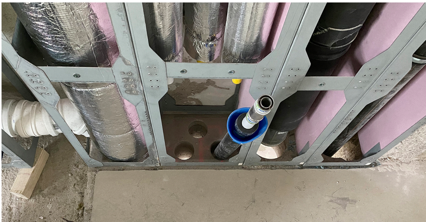
Levyttämättömät Riser Port –elementit timanttiporausaukotusten päällä.
