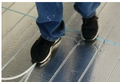
Figure 13 : Enfoncez le tuyau dans la rainure
