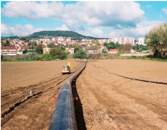
Fot. 2. Przejście pod rzeką metodą przewiertu - Decin, Czechy
