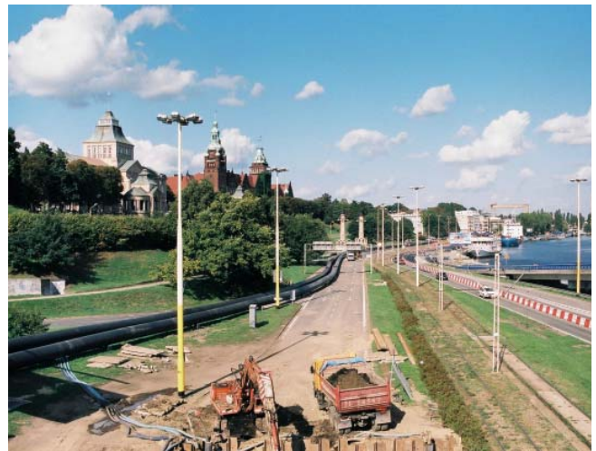
Fot. 4. Przewiert pod rzeką Odrą – Szczecin
