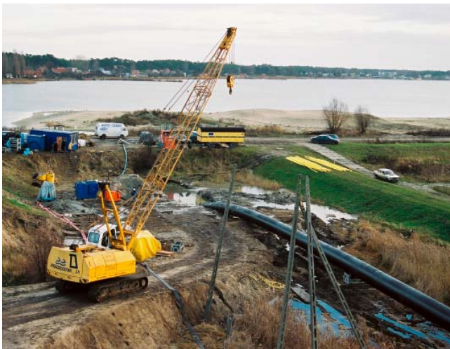
Fot. 3. Przewiert pod Martwą Wisłą – Gdańsk
