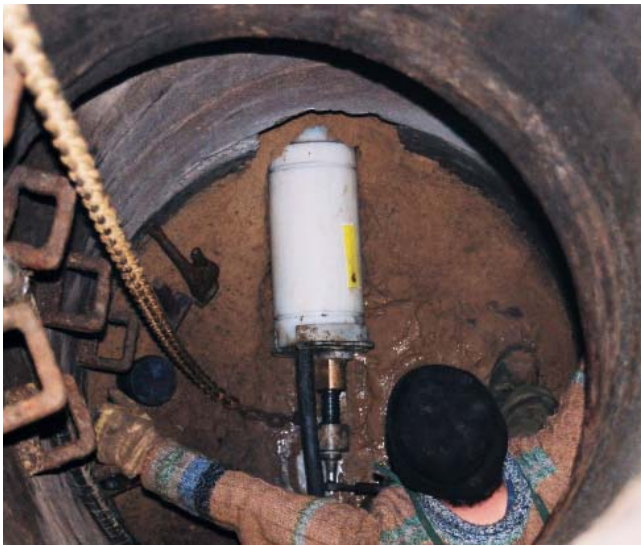
Fot. 6. Renowacja kanału kamionkowego w Warszawie metodą krakingu i reliningu krótkiego za pomocą modułów VipLiner
