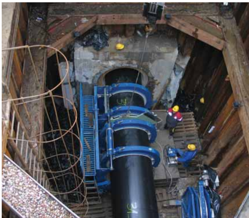
Montaż rur PE o średnicy 1400 mm w komorze pod ulicą Czerniakowską
