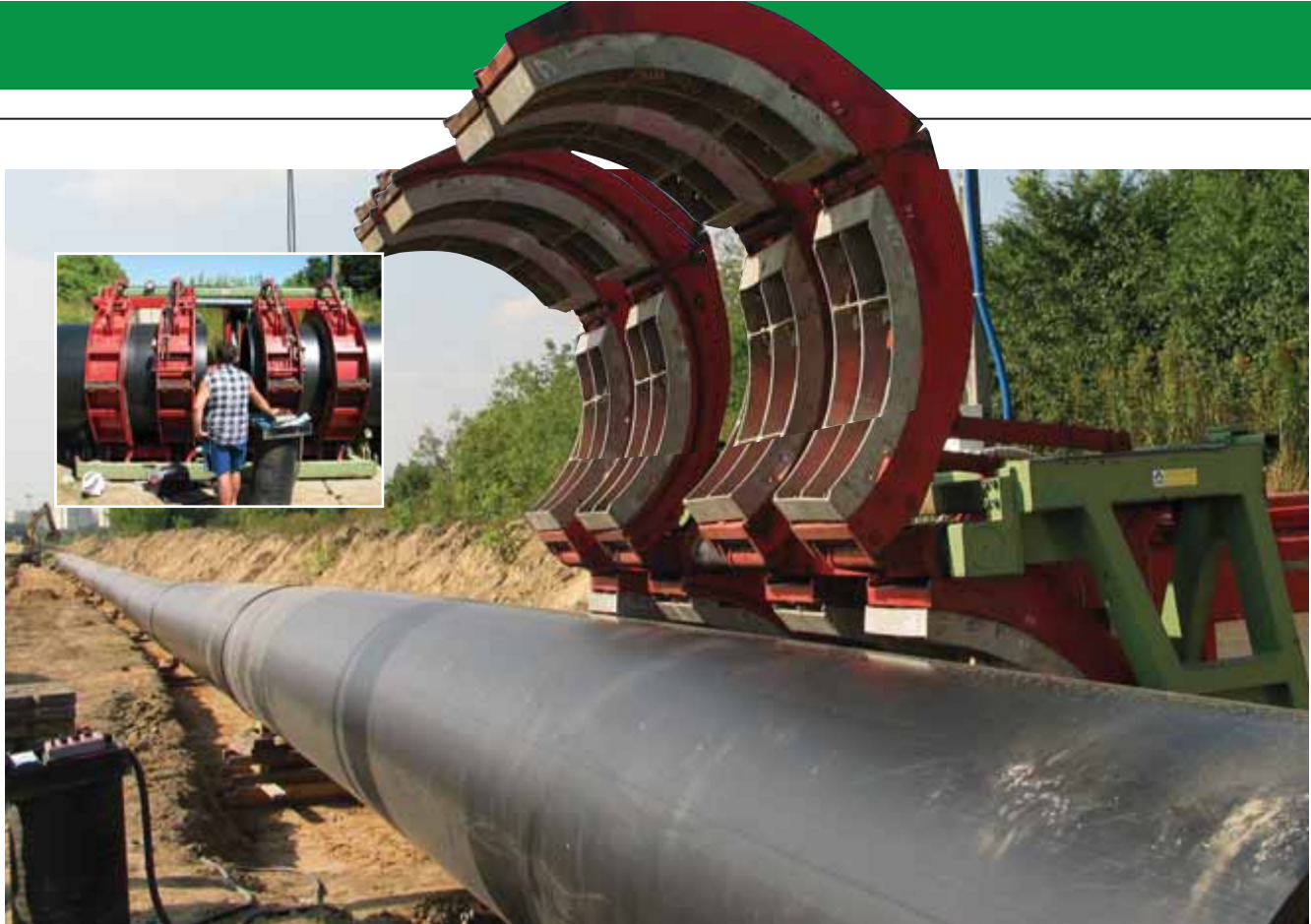
Łączenie rur WehoPipe zgrzewarką KWH Pipe
