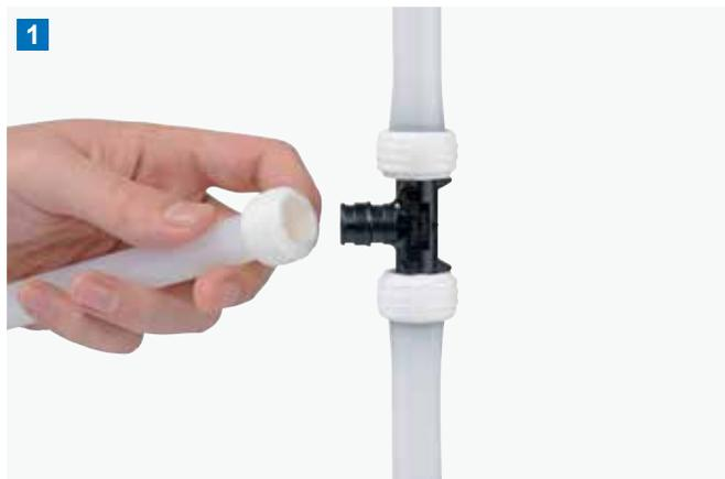
1 Tagliare l'estremità del tubo, inserire l'anello elastico Q&E fino a battuta.
