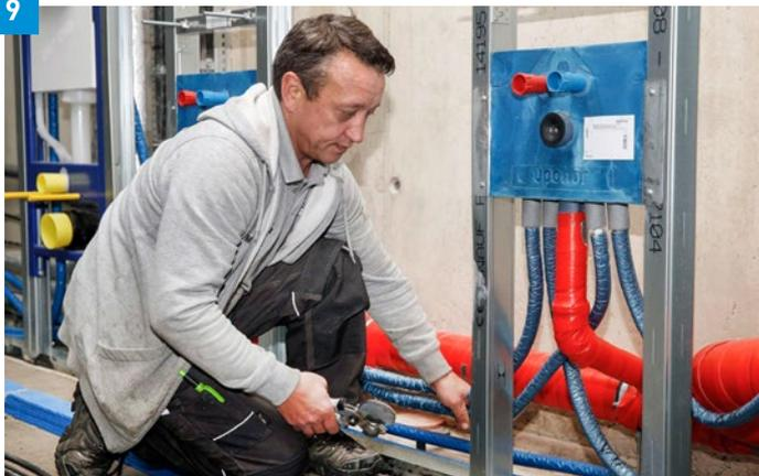
Durch die geringe Anzahl von Verbindungsstellen sowie die Verwendung von nur einem Rohrdurchmesser ermöglicht die Durchschleif-Ringinstallation eine schnelle und einfache Montage.
