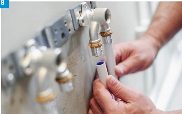
Die Durchschleif-Ringinstallation versorgt die Verbraucher ringförmig von zwei Seiten. Dazu werden die Trinkwasserleitungen an den Zapfstellen mithilfe sogenannter U-Wandscheiben durchgeschleift.
