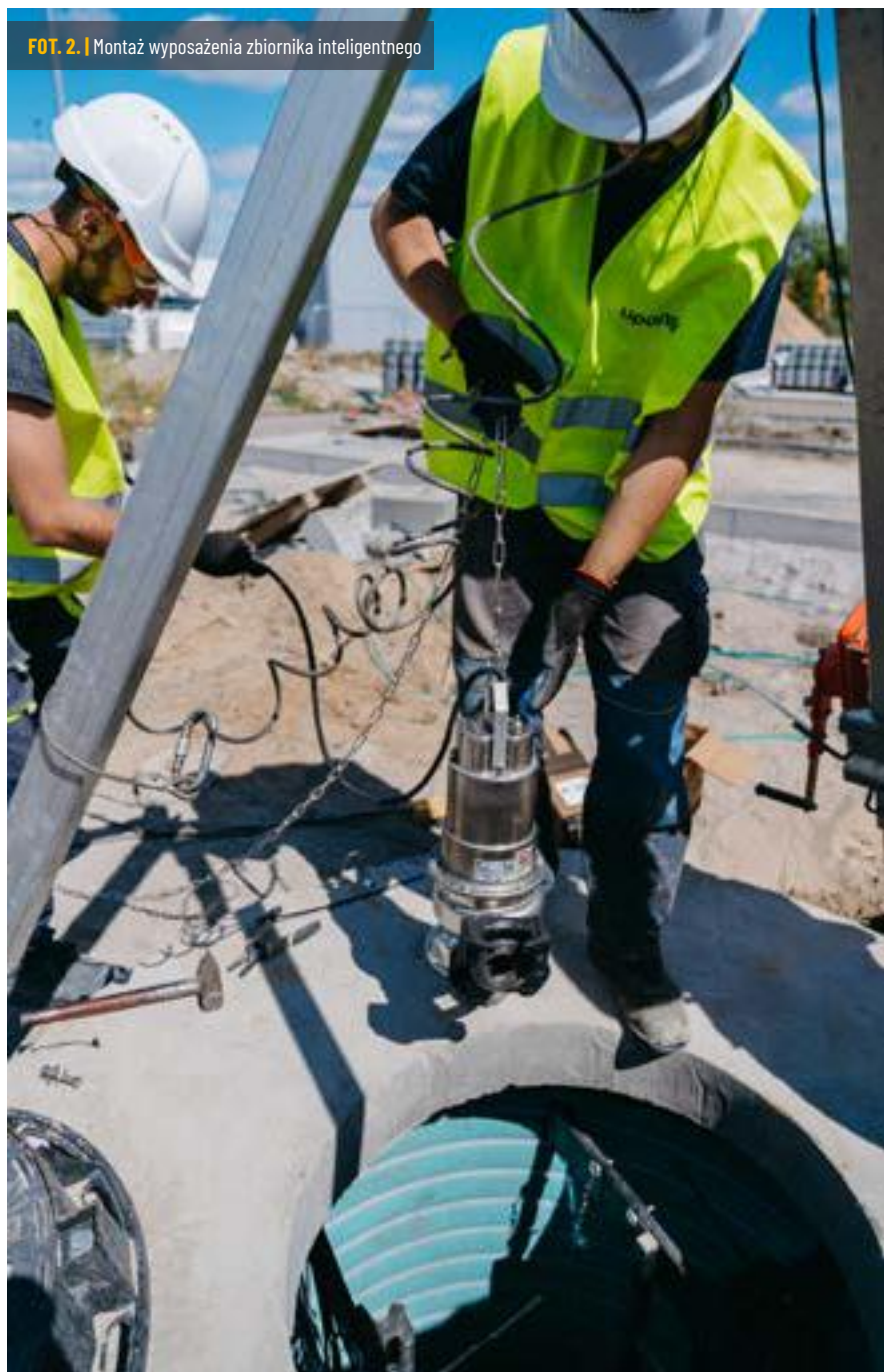
FOT. 1. | Montaż zbiornika inteligentnego
